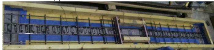
(d) deck reinforcement and formwork
